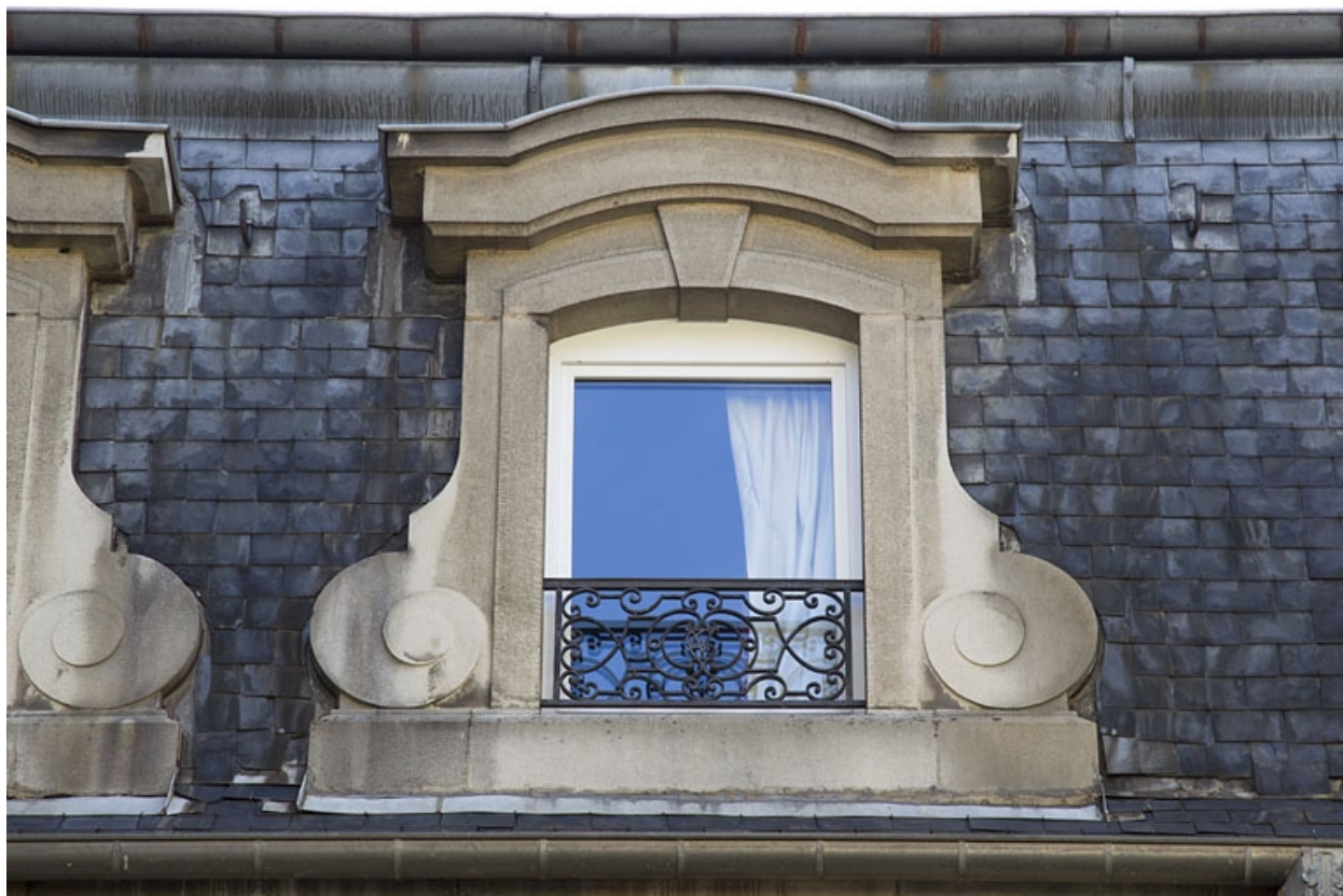
Logis secondaire : détail d'une lucarne.
