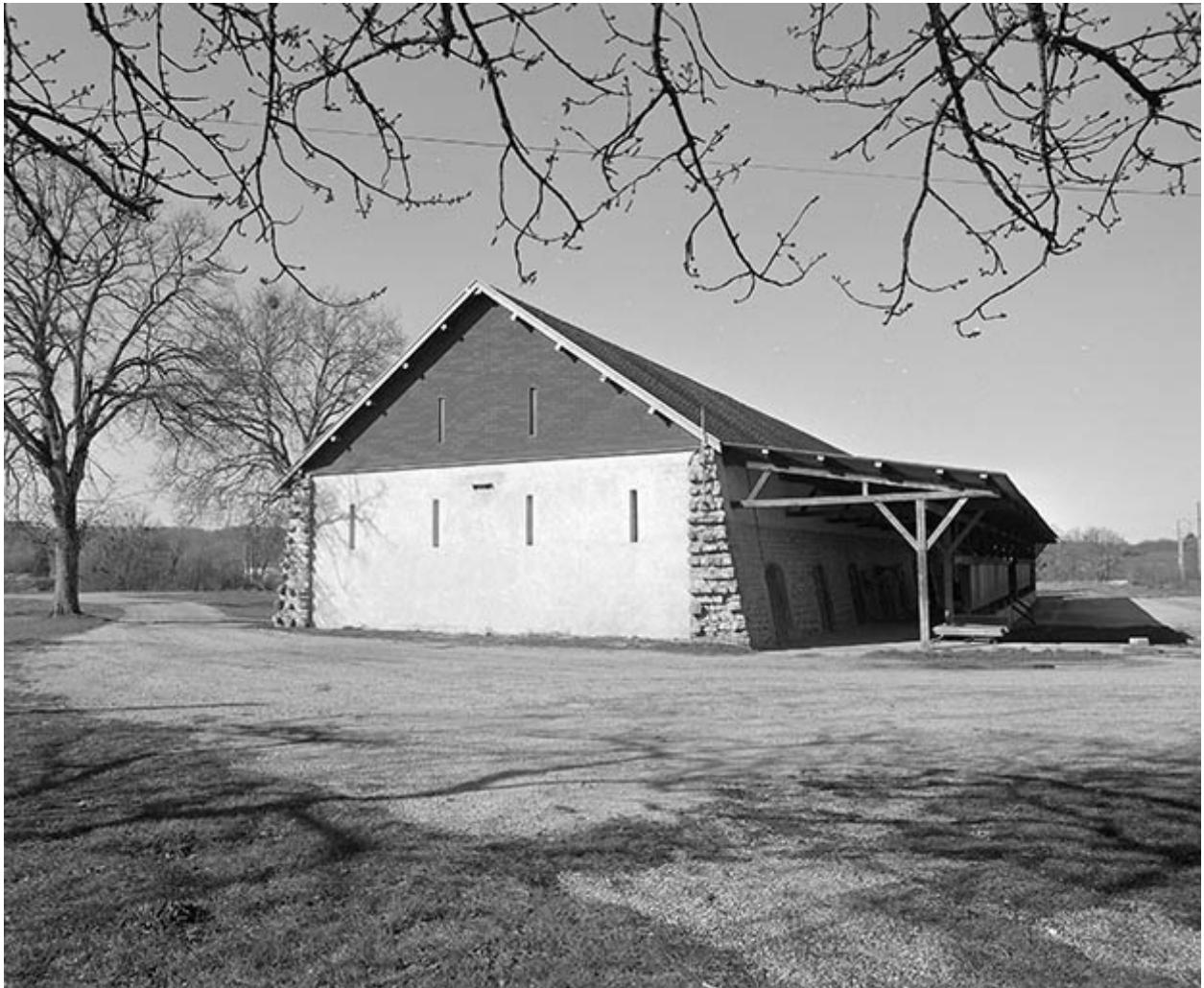
Extrémité orientale du magasin industriel.
