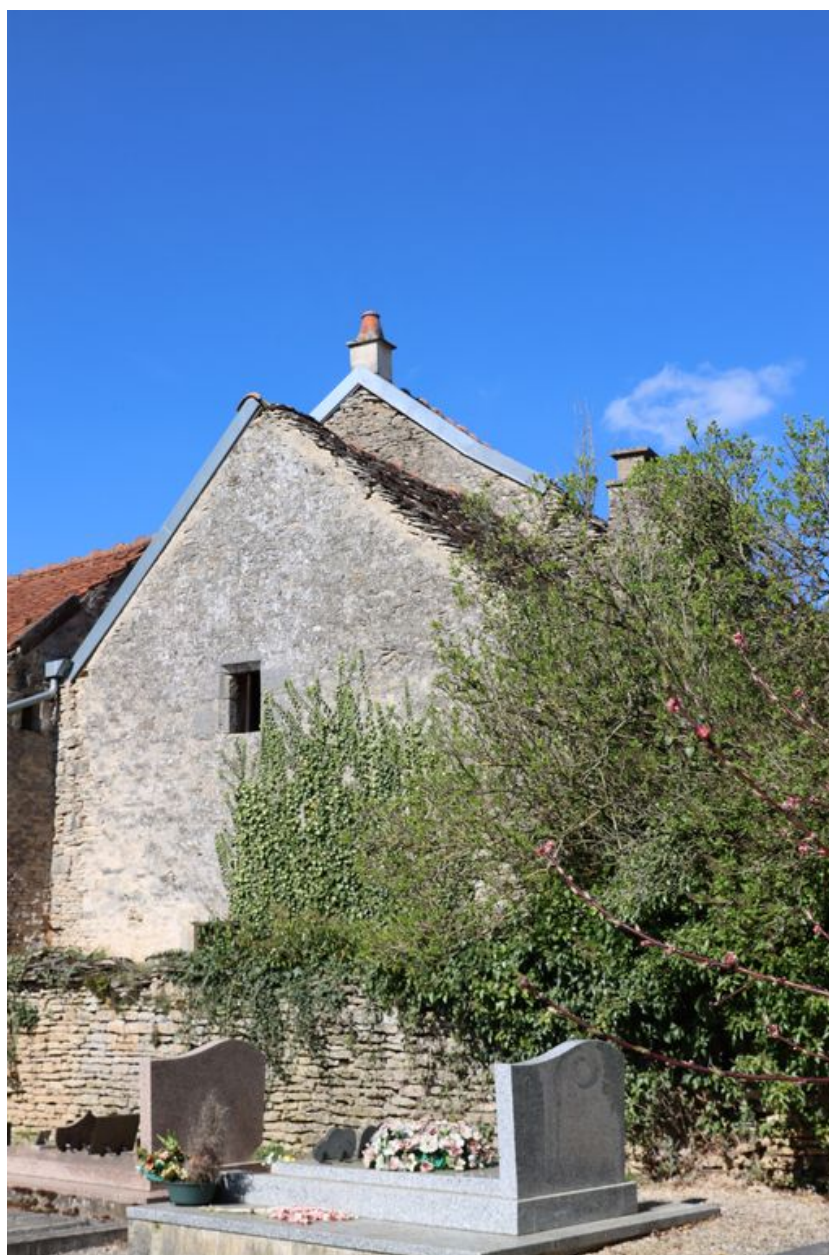
Vue du mur pignon de l'extension Sud.
