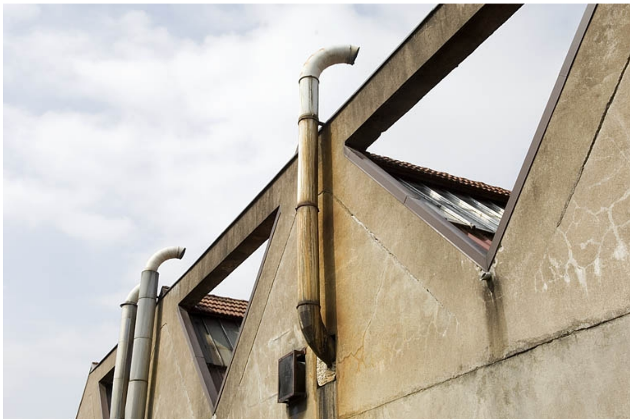
Pignons de l'atelier de fabrication. Détail.
