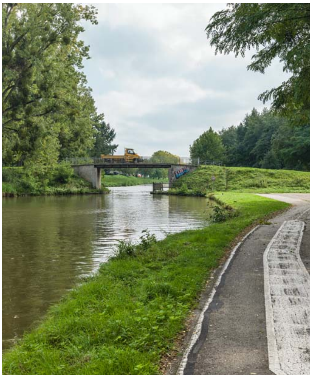
Vue d'ensemble du pont.
