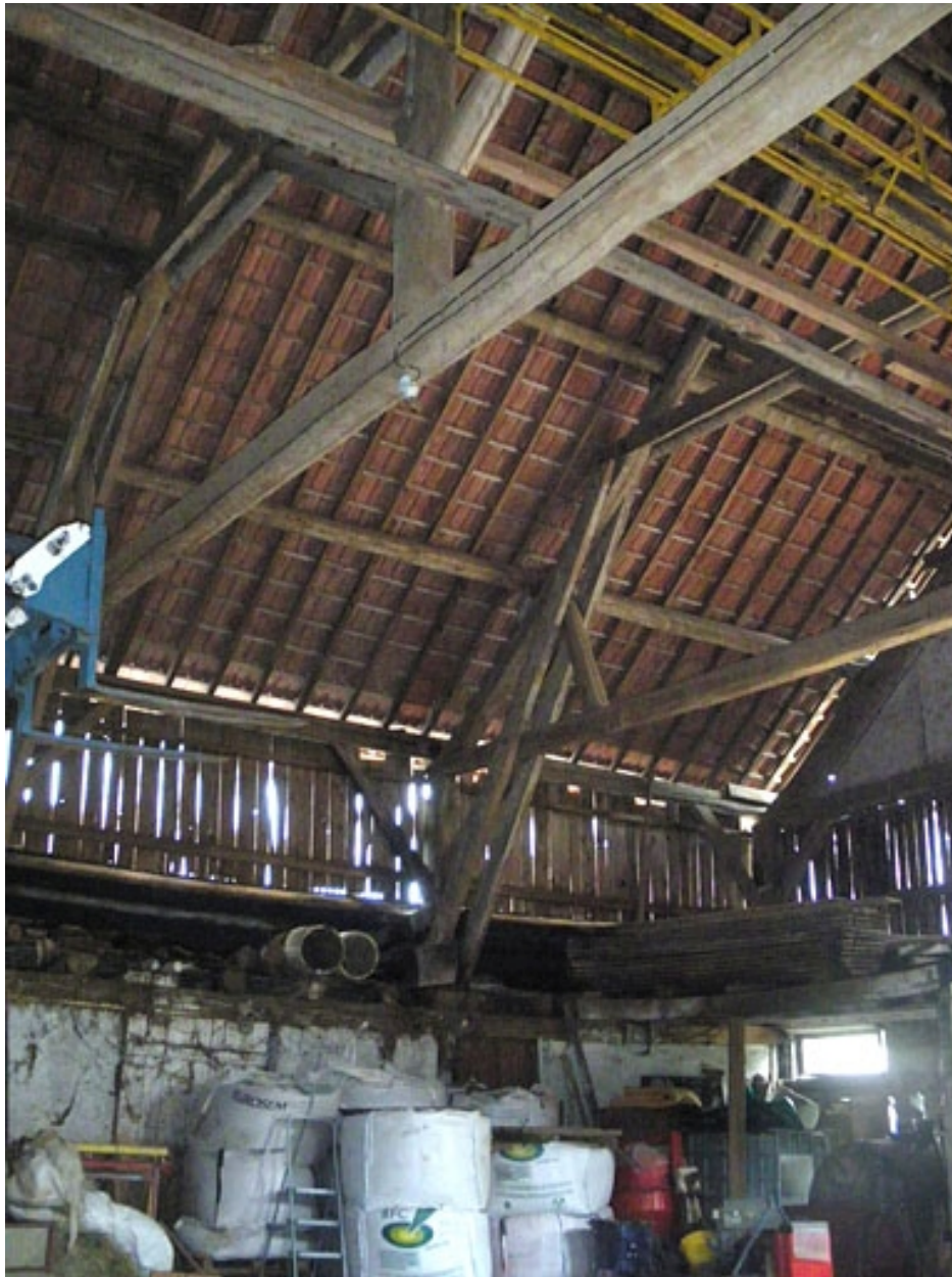
Remise agricole : charpente.
