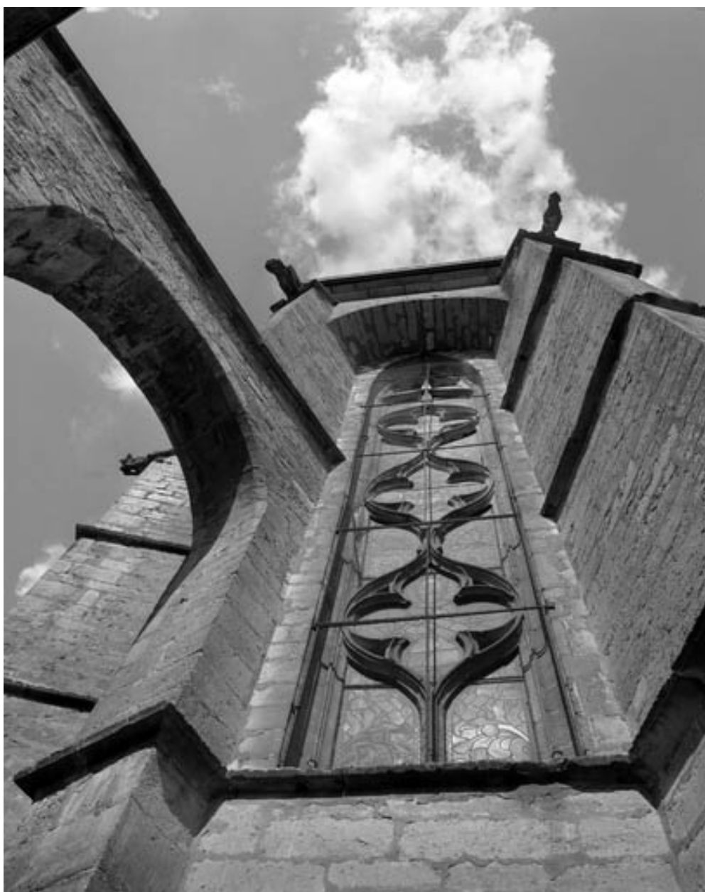
Chevet : détail d'une baie.
