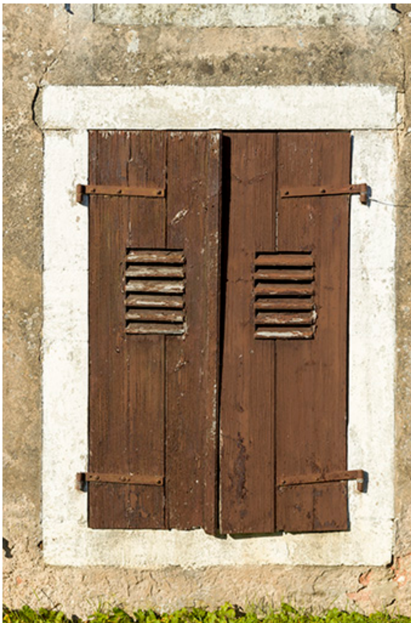
Détail d'une baie avec ses volets.
