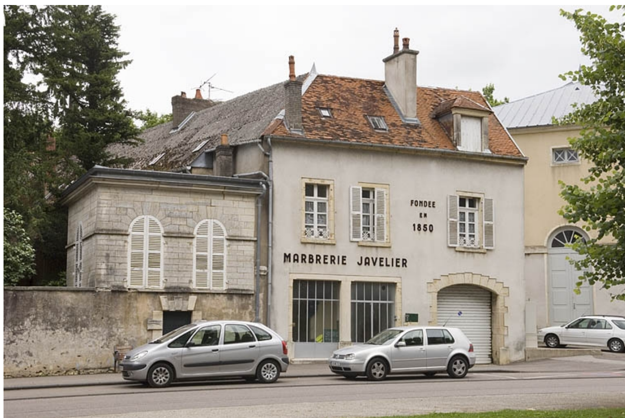
Vue d'ensemble depuis la rue Revon.
