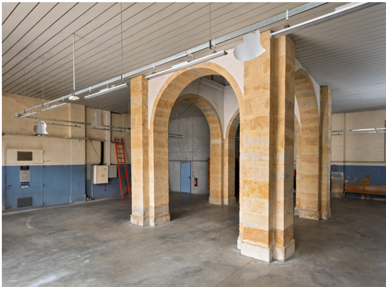
Rez-de-chaussée, halle : vue d'ensemble.
