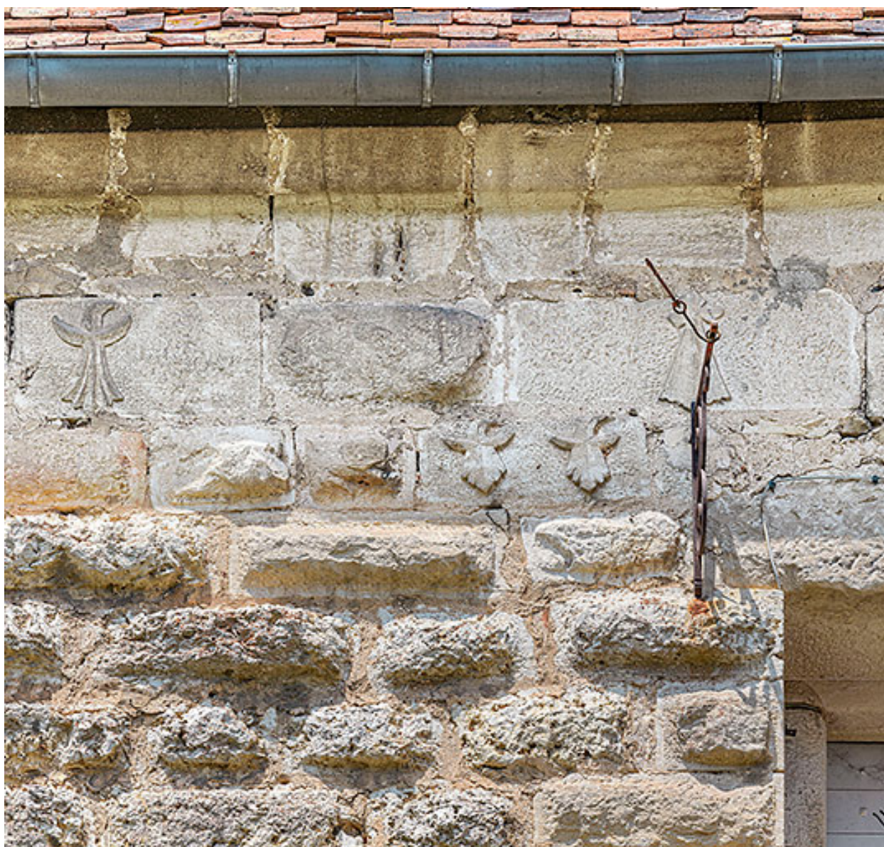
La maçonnerie en bossage de la porte.
