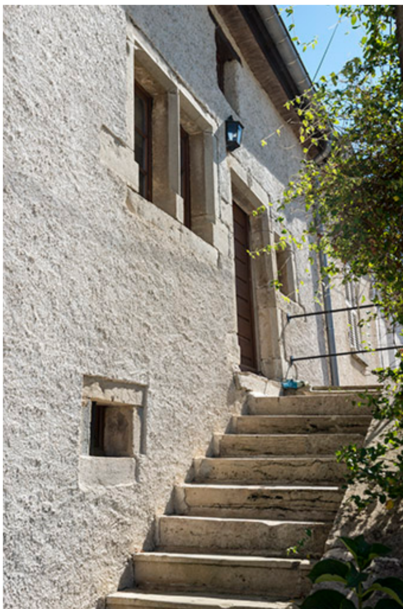
L'escalier extérieur permettant d'accéder à l'étage carré.
