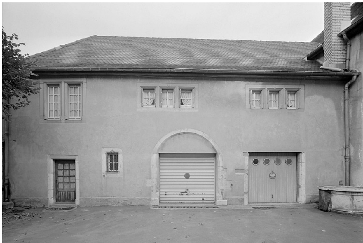
Aile gauche. Façade sur la cour.
