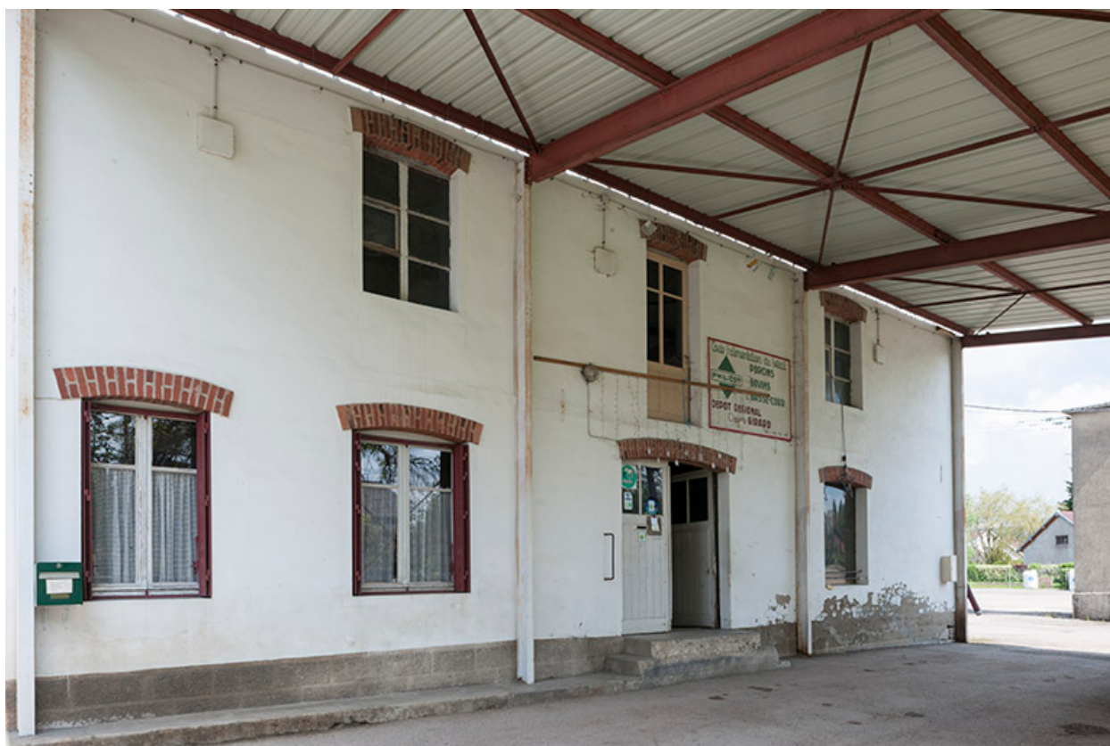
Façade est de la minoterie.
