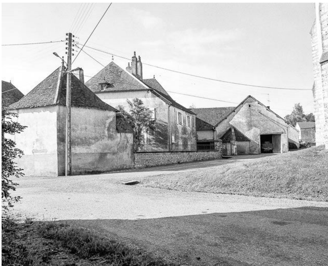
Vue d'ensemble : façade postérieure.
