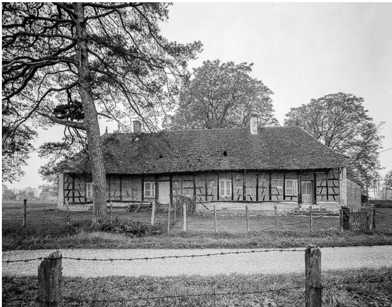
Bâtiment d'habitation vu de face en 1975.
