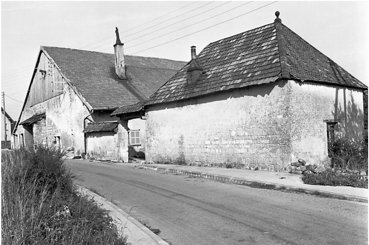
Ferme située 11 rue du Village.
