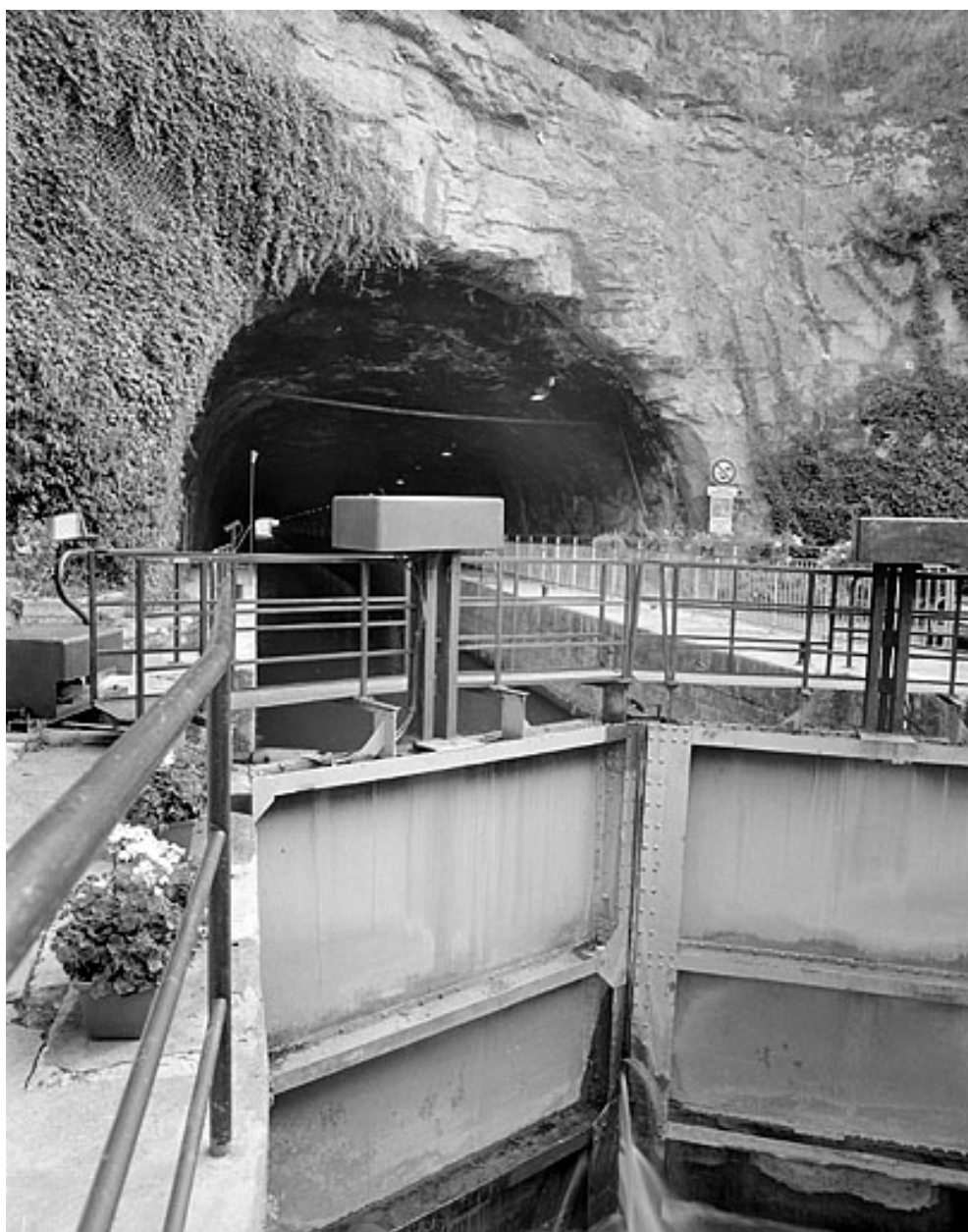
Porte aval de l'écluse et tunnel.
