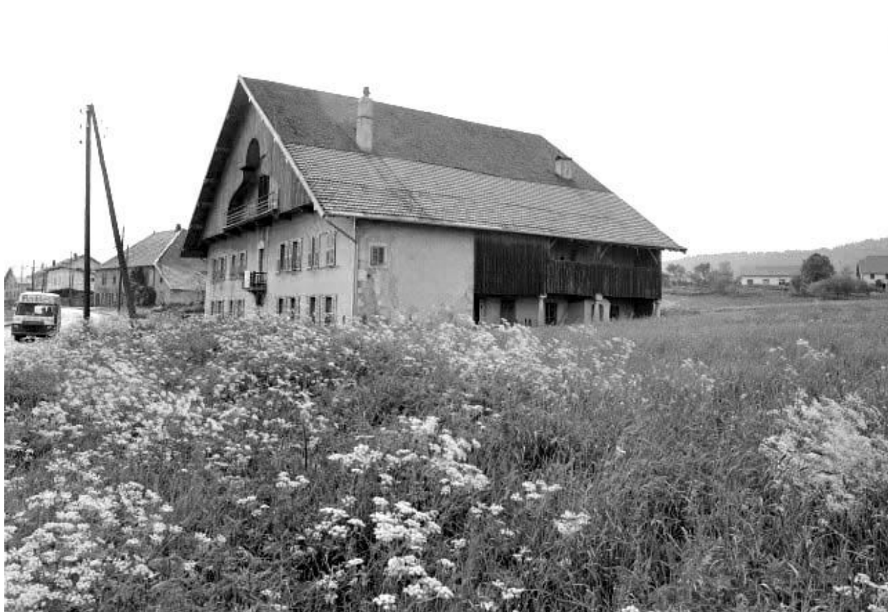
Façades antérieure et latérale droite.
