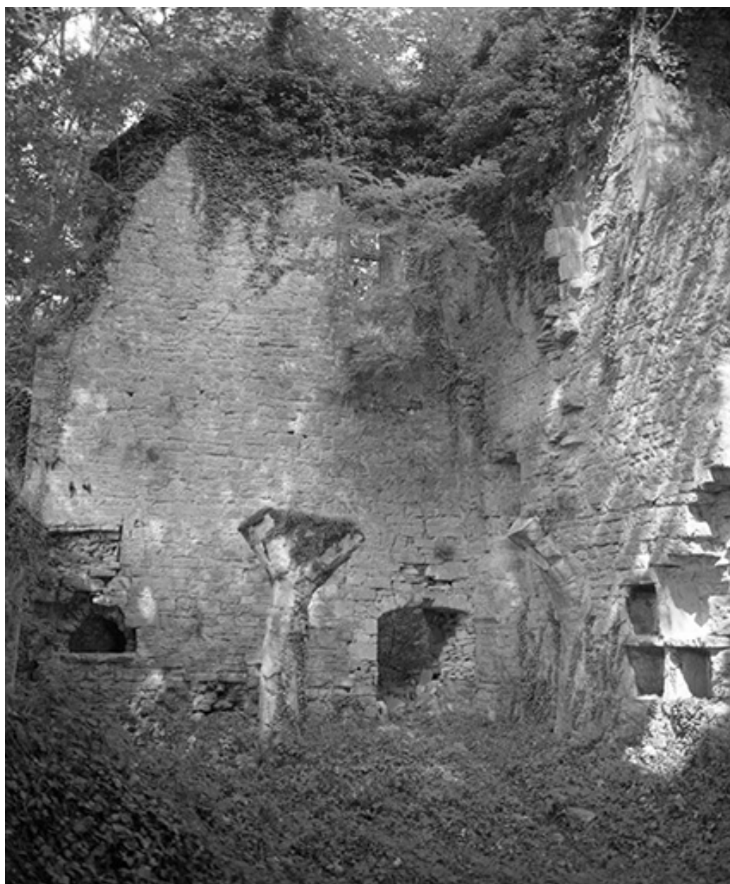
Chapelle du château, vue intérieure.
