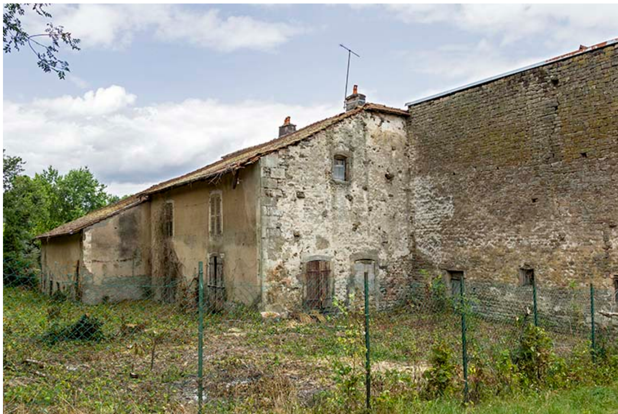
Vue générale sur la façade postérieure.
