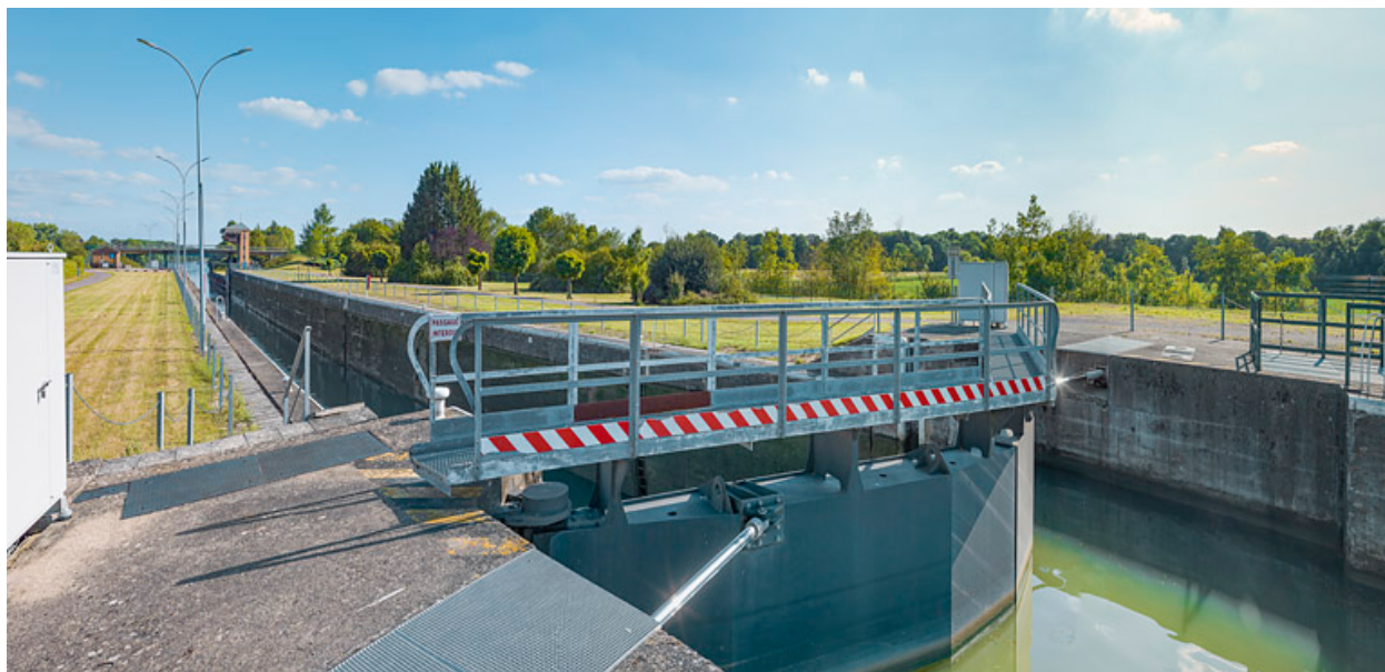
Vue d'ensemble des portes amont de l'écluse.
