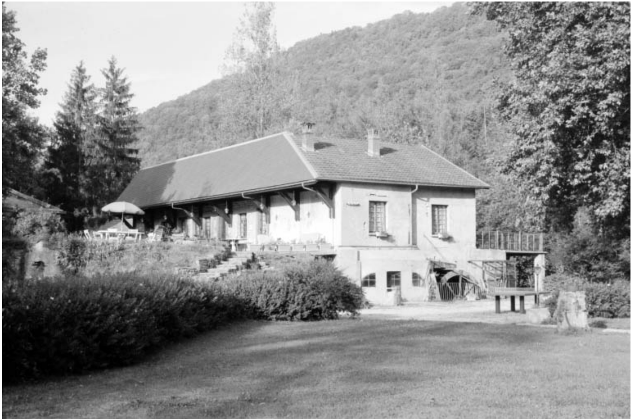
Bâtiment d'eau, vu de trois quarts droite.
