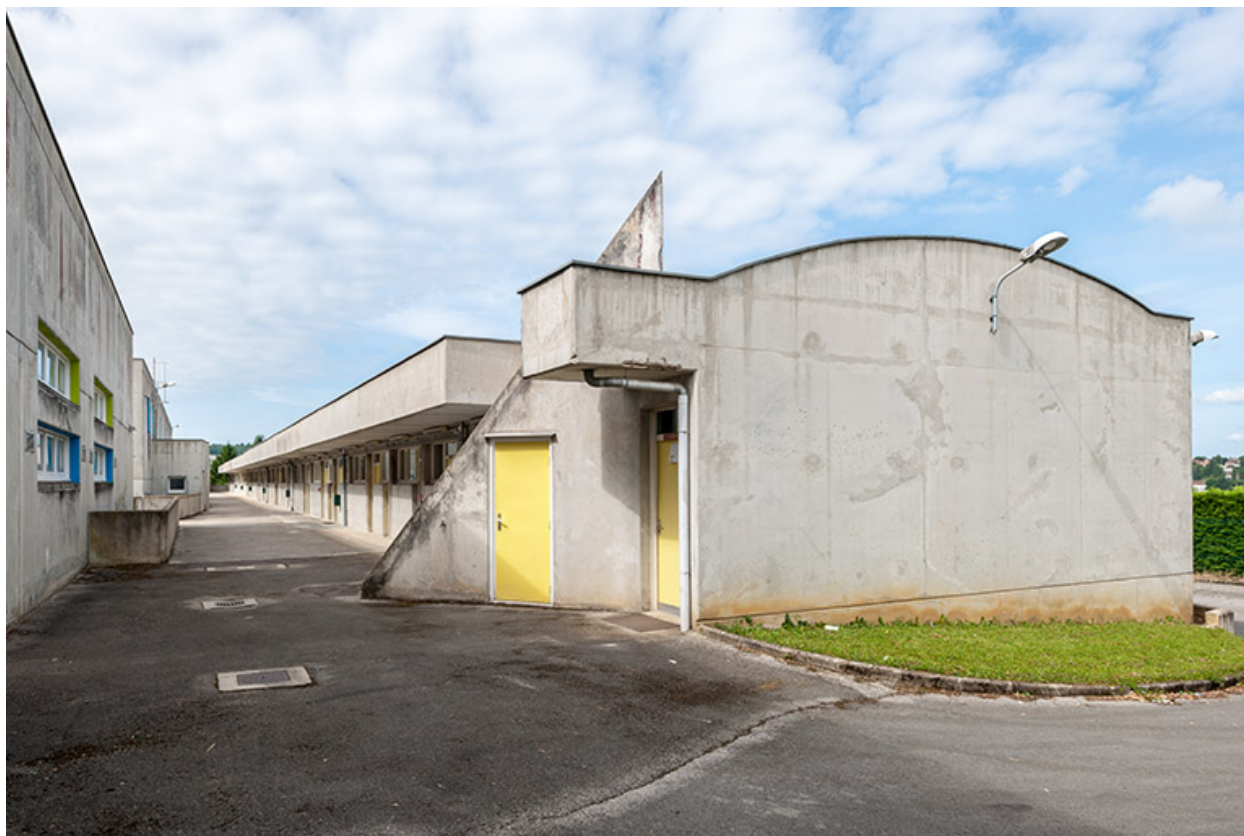
Externat : pignon nord
