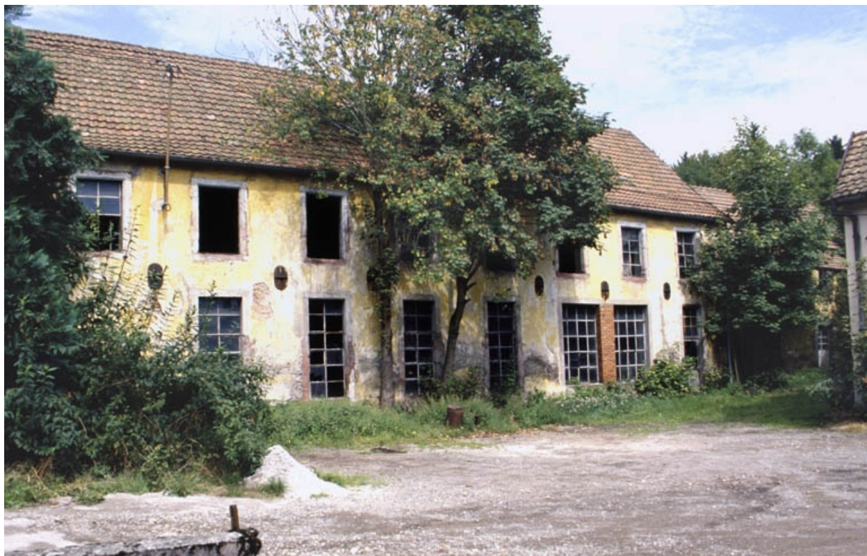
Atelier de réparation depuis la cour.
