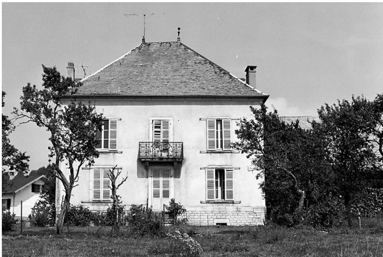
Façade postérieure du logis.
