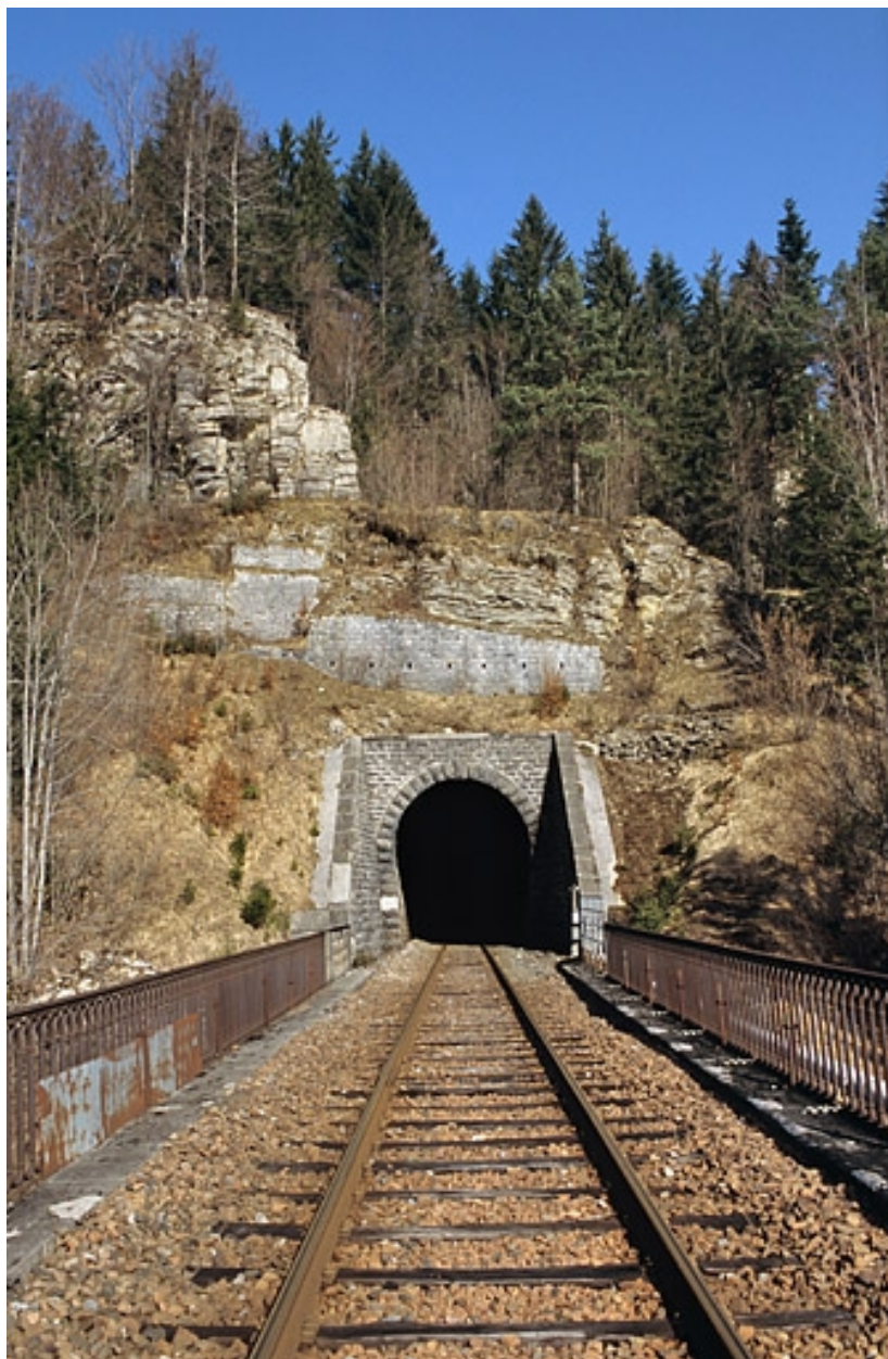
Tunnel : tête du côté La Cluse.
