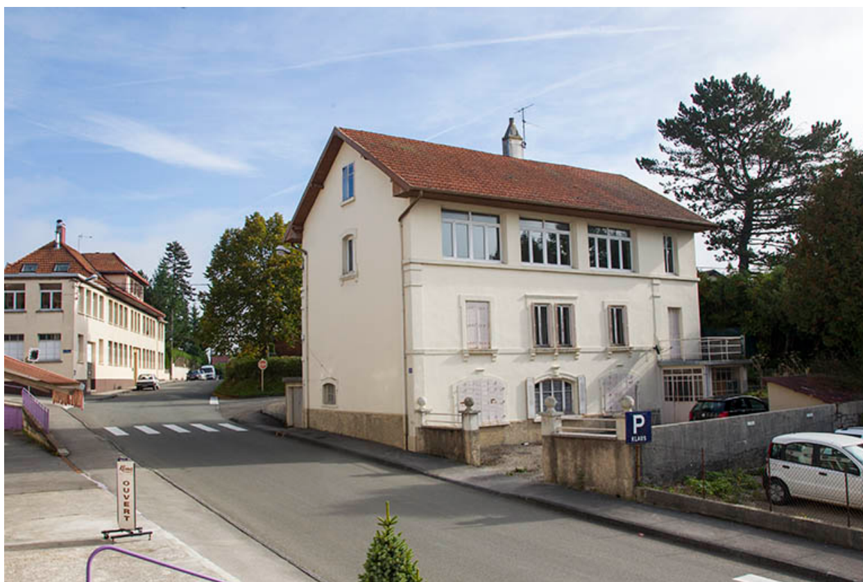
Façades antérieure et latérale gauche.
