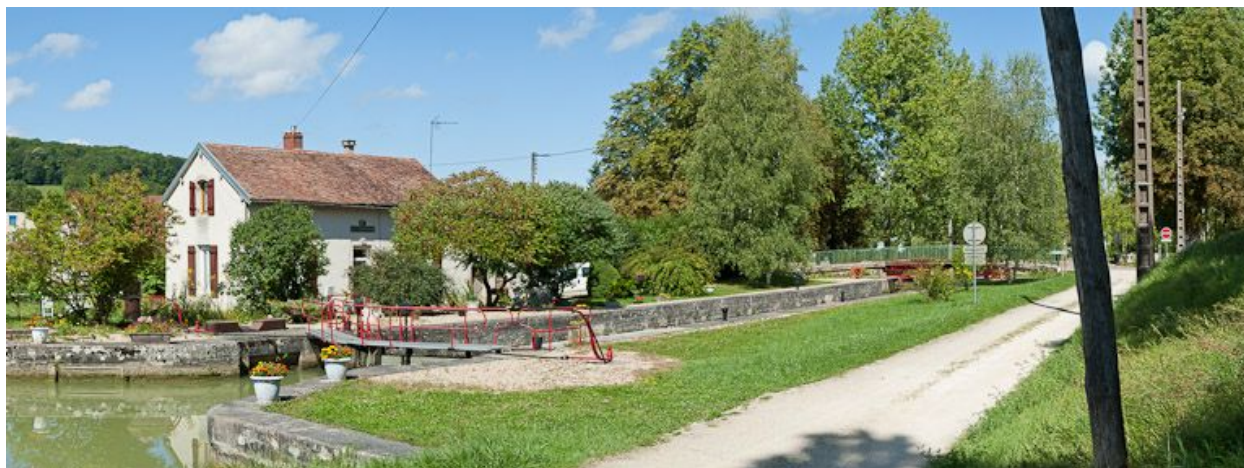
Vue d'ensemble du site d'écluse.
