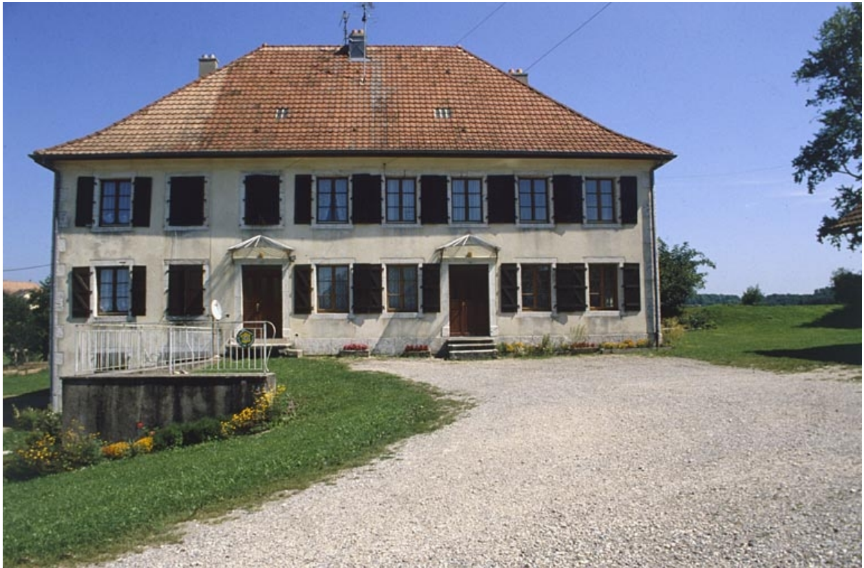
Façade ouest du logement patronal.
