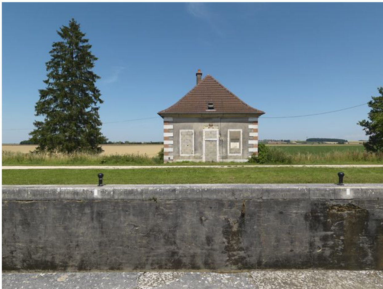
Maison éclusière : vue de face.
