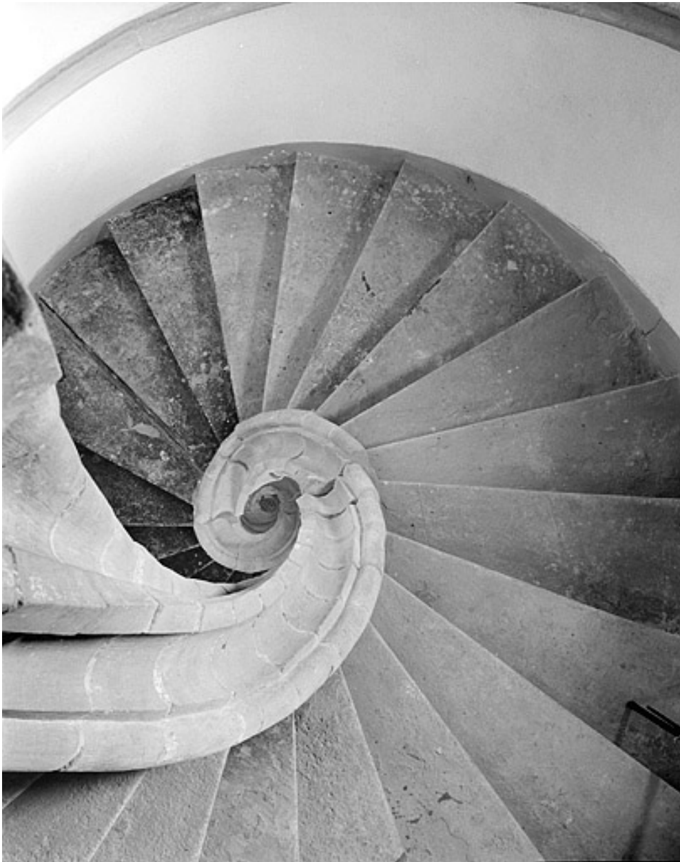
Escalier vu du niveau des combles.
