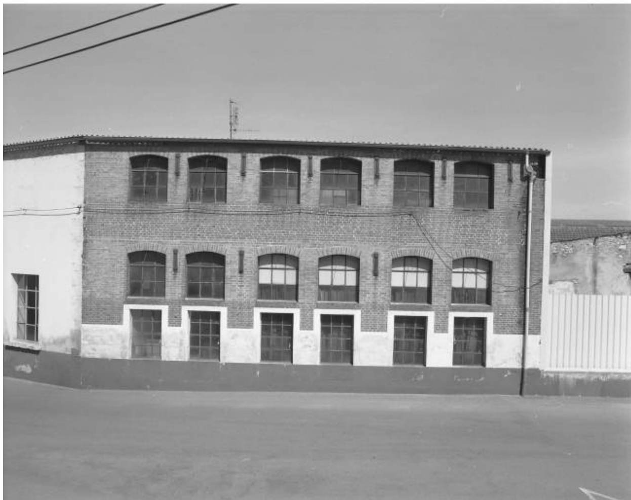
Atelier de contrôle. Vue de face.
