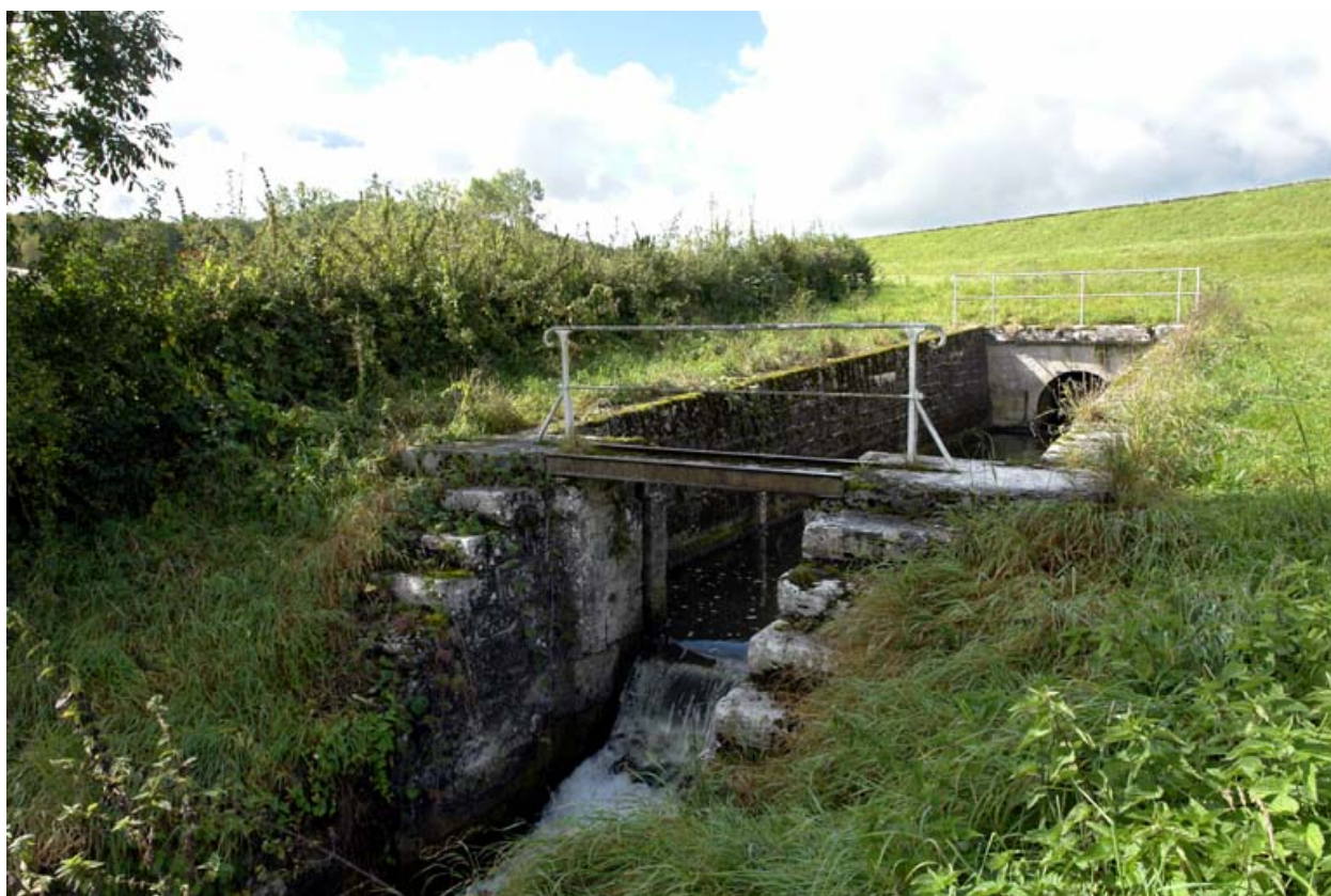
Aqueduc de vidange au centre de la digue principale.
