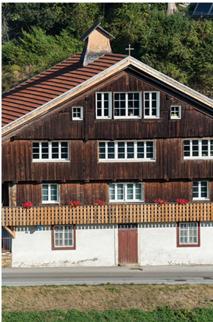
Façade antérieure : travées centrales.
