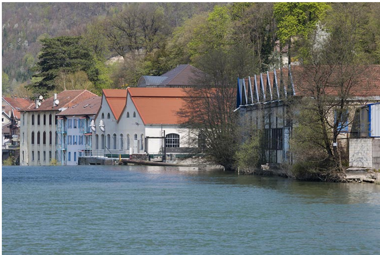
Vue de l'usine rive droite depuis l'amont.
