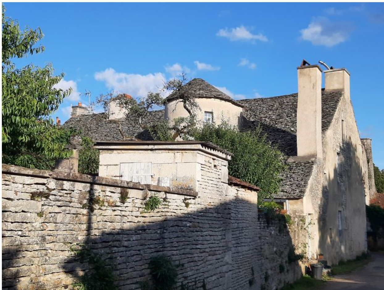
Vue de la demeure depuis le nord-ouest.
