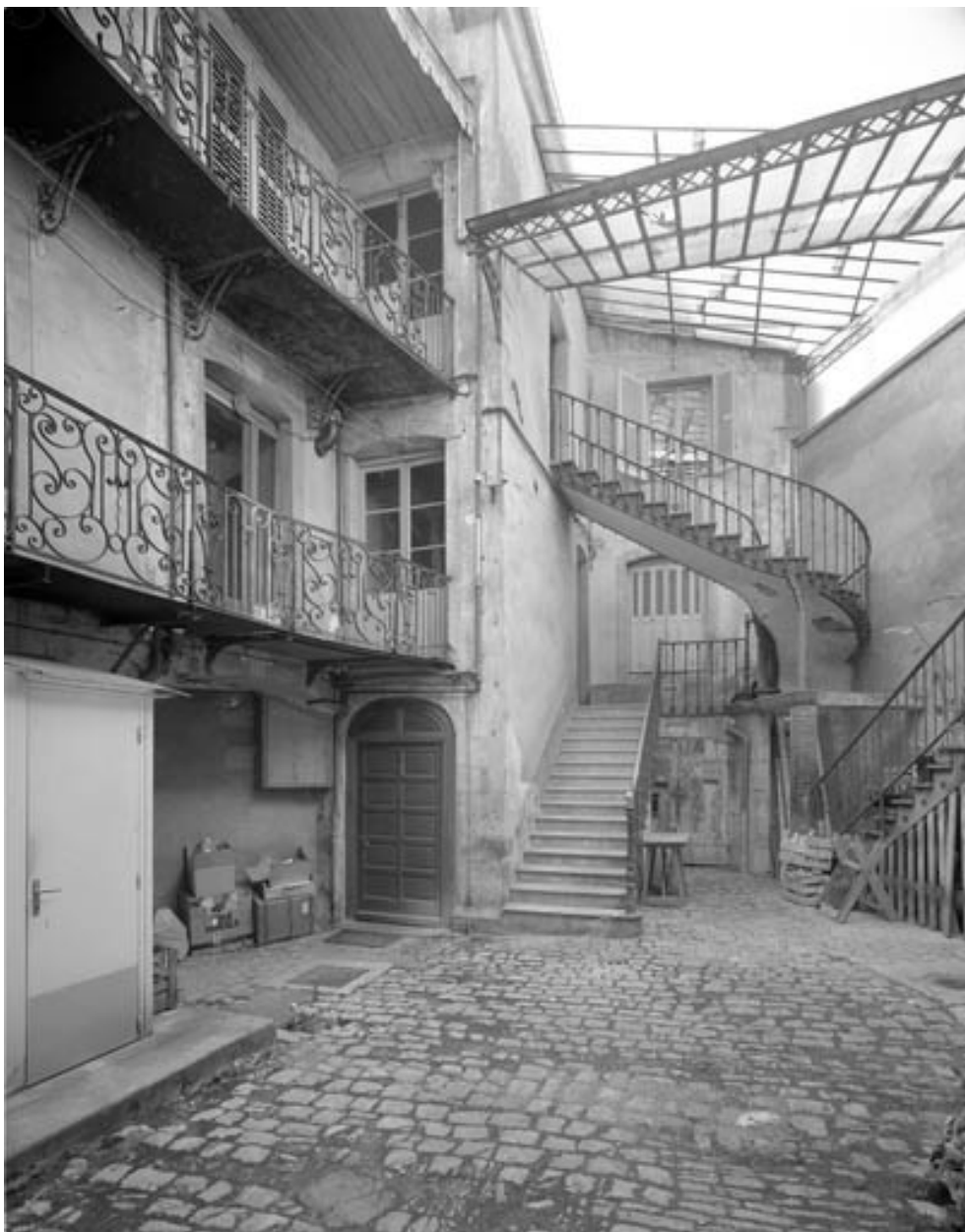
Façade postérieure sur cour.
