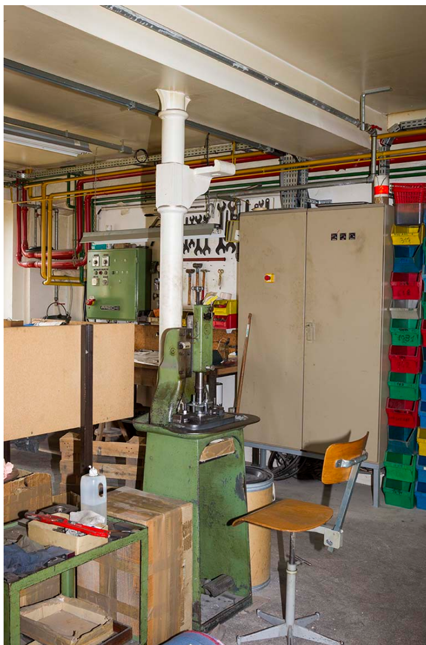
Usine, rez-de-chaussée : poteau de soutènement de l'étage.
