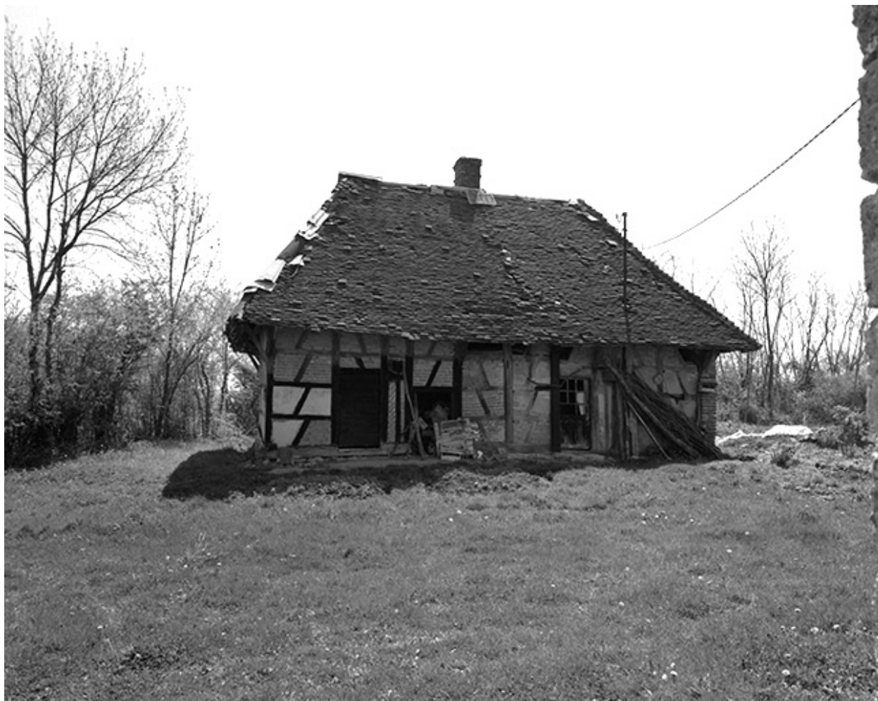
Ferme cadastrée 1969 AL 137 : vue d'ensemble.
