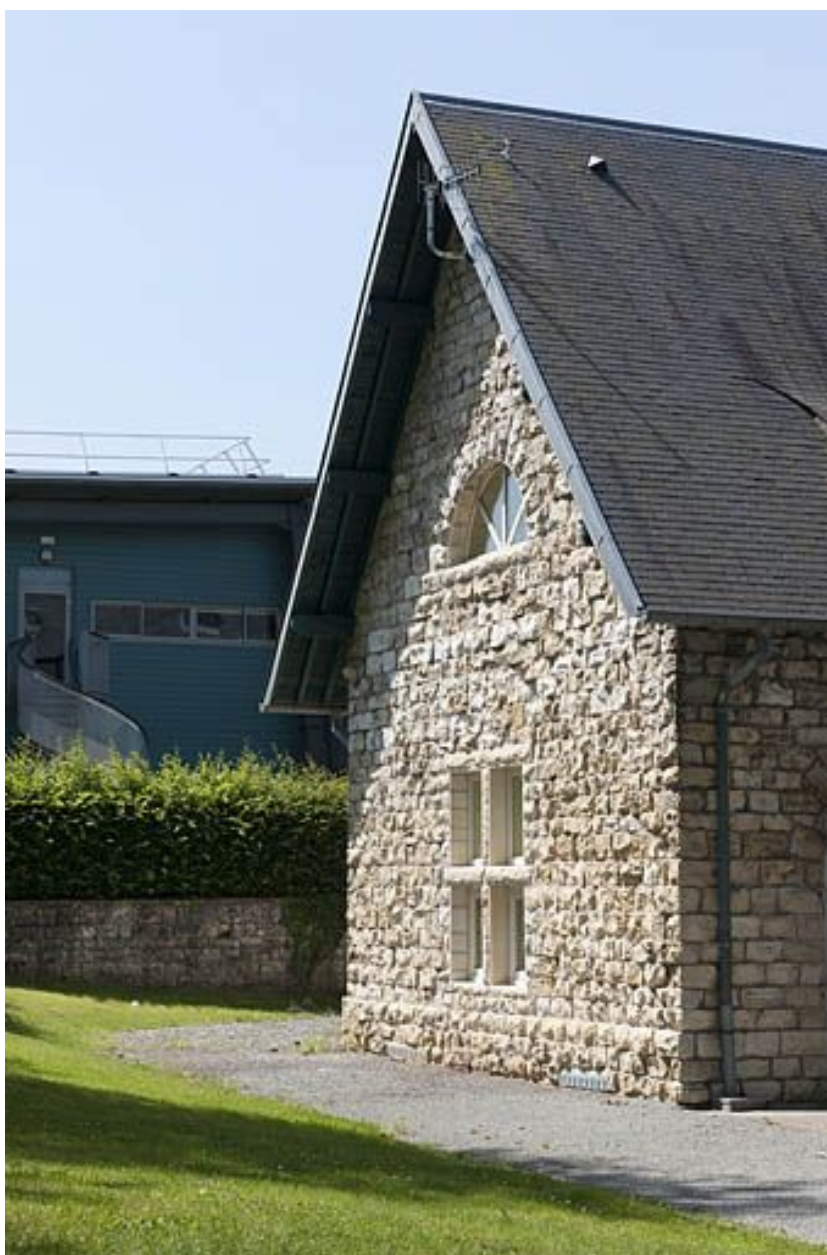
Conciergerie. Pignon sud de la façade postérieure.
