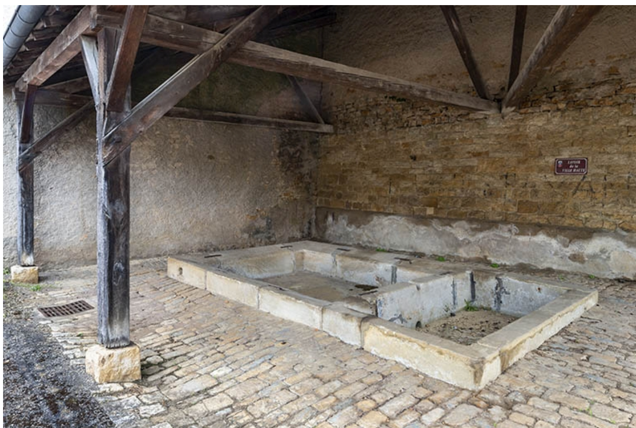
L'intérieur du lavoir.
