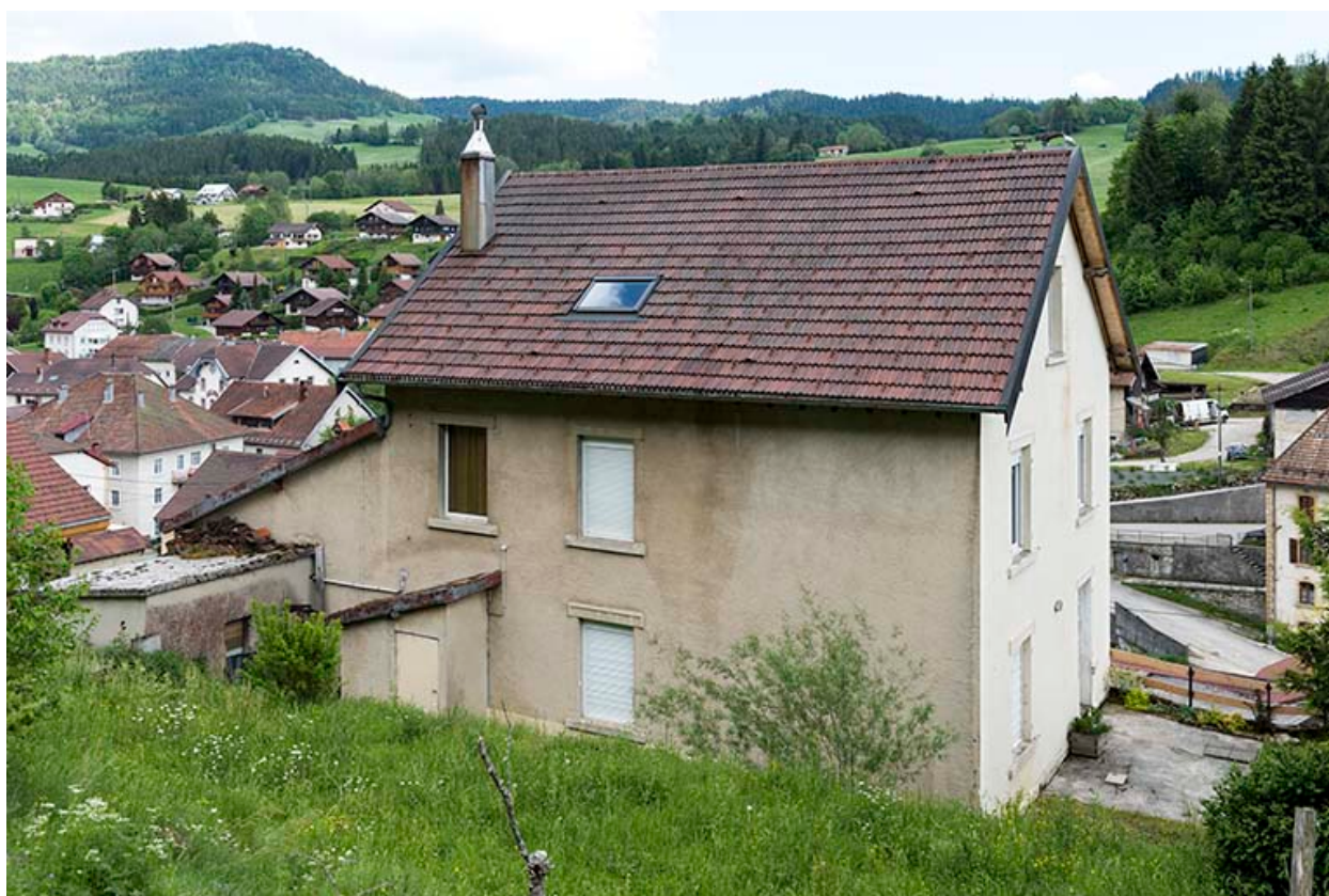
Façades postérieure et latérale gauche.
