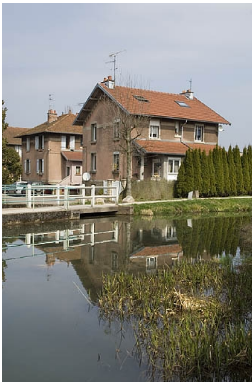
Logements ouvriers vus de trois quarts.
