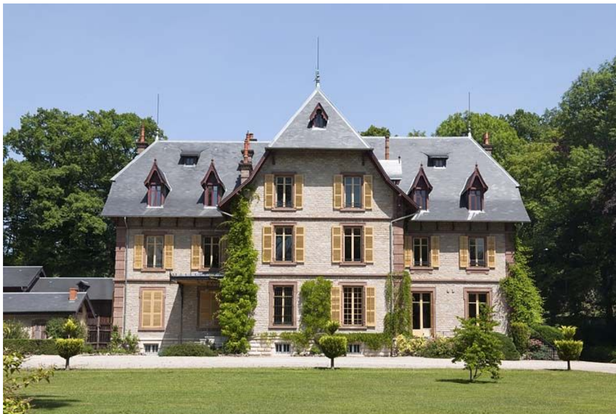
Vue rapprochée de la façade antérieure.
