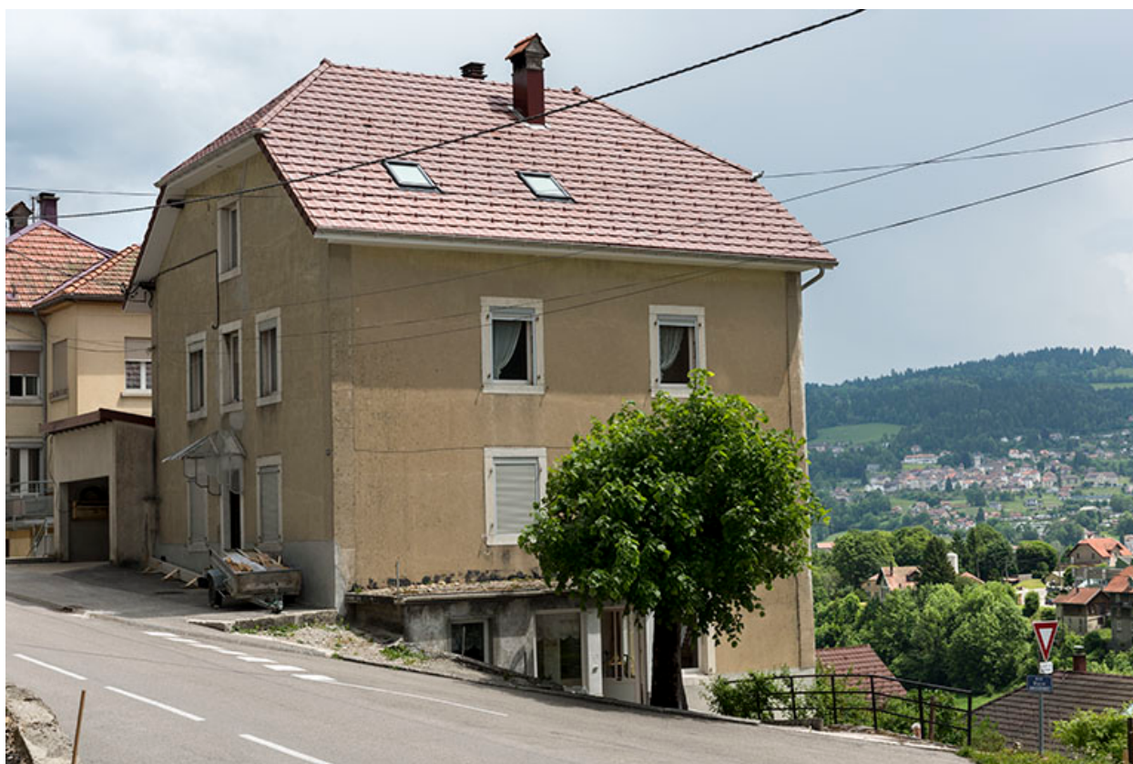
Façades antérieure et latérale droite.
