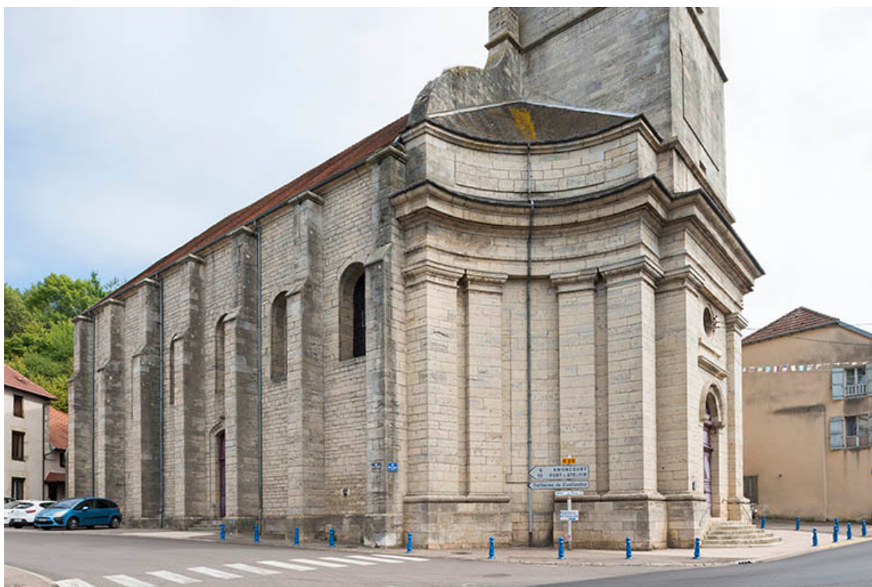
Le mur latéral ouest de l'édifice.
