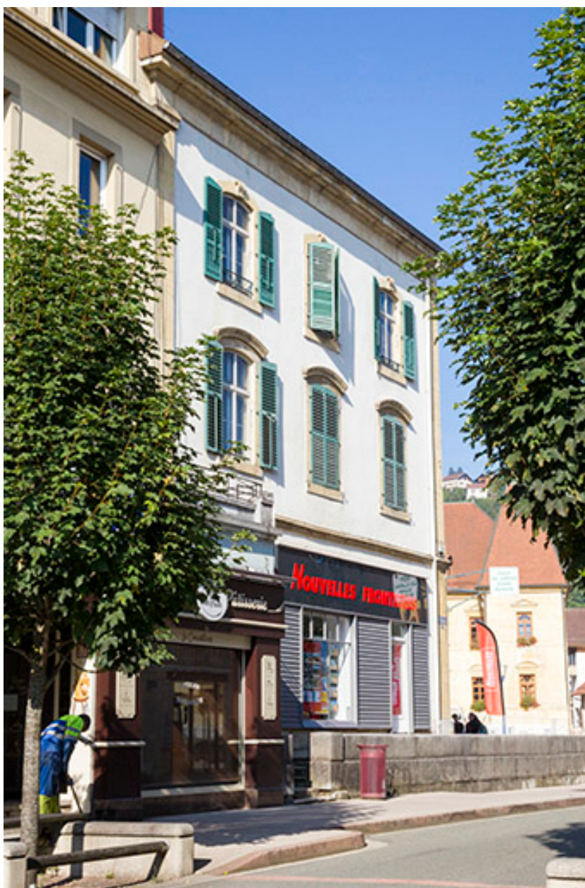
Façade latérale gauche, de trois quarts gauche.
