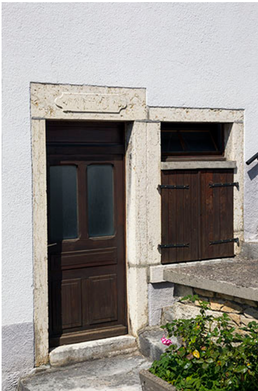
Façade latérale droite : porte avec linteau daté.
