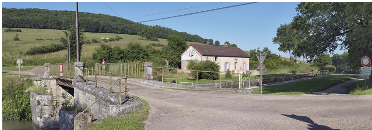
Site d'écluse vu d'aval.
